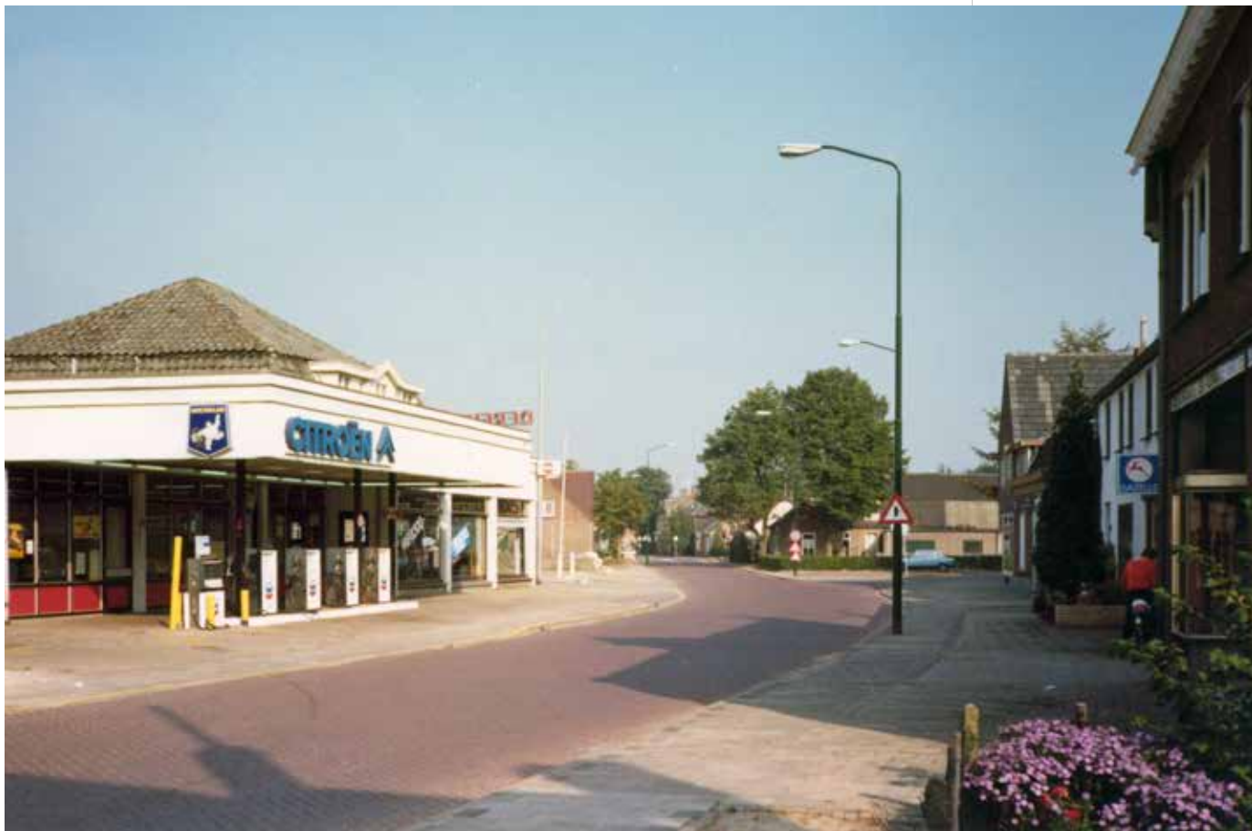
Garage en pompstation na de verbouwing van 1970.
