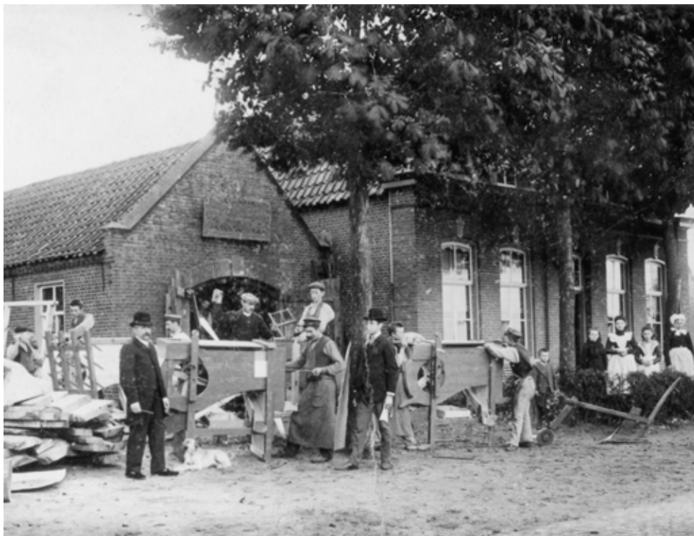
Aan de Willibrorduslaan 7-9 lag de Wanmolenfabriek 'De Gele Duif' van Paulus van Mierlo. Een wanmolen is een landbouwwerktuig om het koren te zuiveren van kaf, strootjes en andere ongerechtigheden. Met een handzwengel wordt een schoepenrad in een trommel rondgedraaid, waardoor er een luchtstroom ontstaat. Het graan valt vanuit een voorraadbak langzaam naar beneden, terwijl het kaf wordt weggeblazen. Later kwamen er machinaal aangedreven molens en weer later ging men over op het gebruik van een maaidorser.
